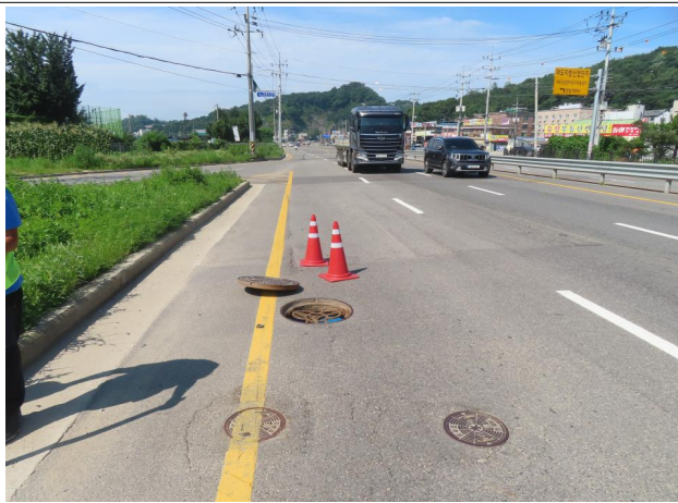
Sta.67+10 시점부 전경
