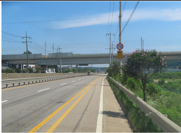
Sta.36+35 시점부 전경
