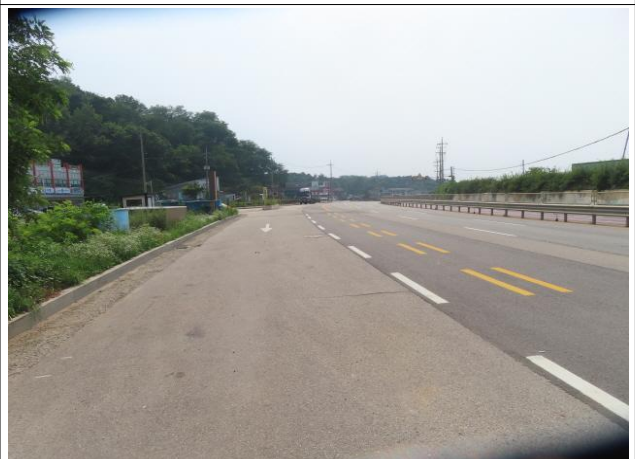
Sta.104+03 시점부 전경
