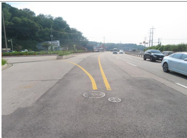
Sta.97+08 시점부 전경
