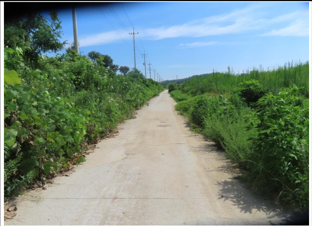
Sta.52+08 시점부 전경
