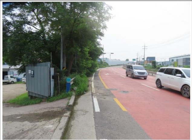
Sta.79+01 시점부 전경
